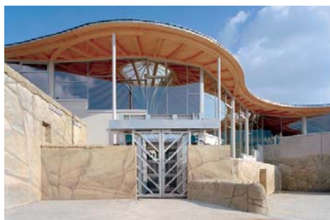
Anspruchsvolle Montage: das Elefantenhaus
